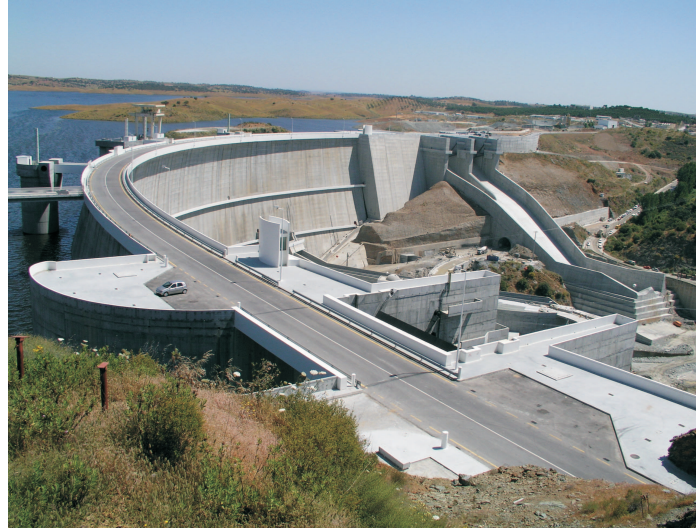
Figura 6.71: Presa de Alqueva. Perspectiva.
