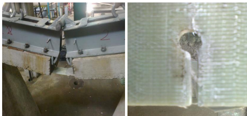
Figura 15 - Ensayos n° 7 y n° 8: Lámina con un bulón 8.8 en cada extremo despegue sin colapso y con resistencia resiliente
