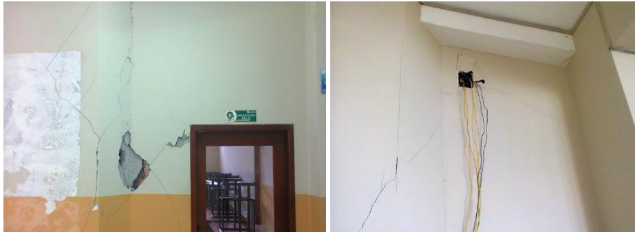
Figura 5. Paredes que no son rectas con daño en la Facultad de Informática durante el terremoto de 2016
