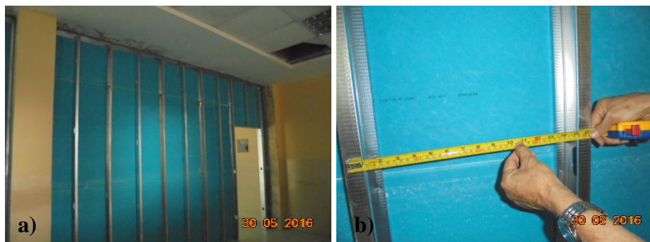
Figura 11. Colocación de estructura de Gypsum: a) elementos verticales con perfiles G en tol de 1 mm, de espesor; b) Espaciamiento de 41 cm
