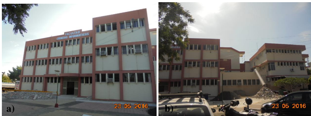
Figura 3. Fachada de edificio de Facultad de Informática de ULEAM
