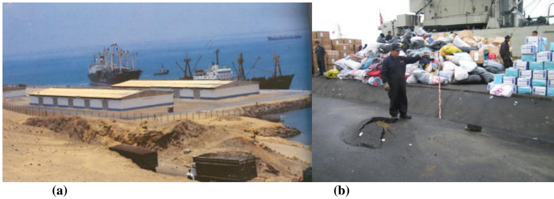
Figura 22: (a) Suelo ganado al mar; (b) Distorsión vertical de 0.8 m entre embarcadero y relleno artificial.
