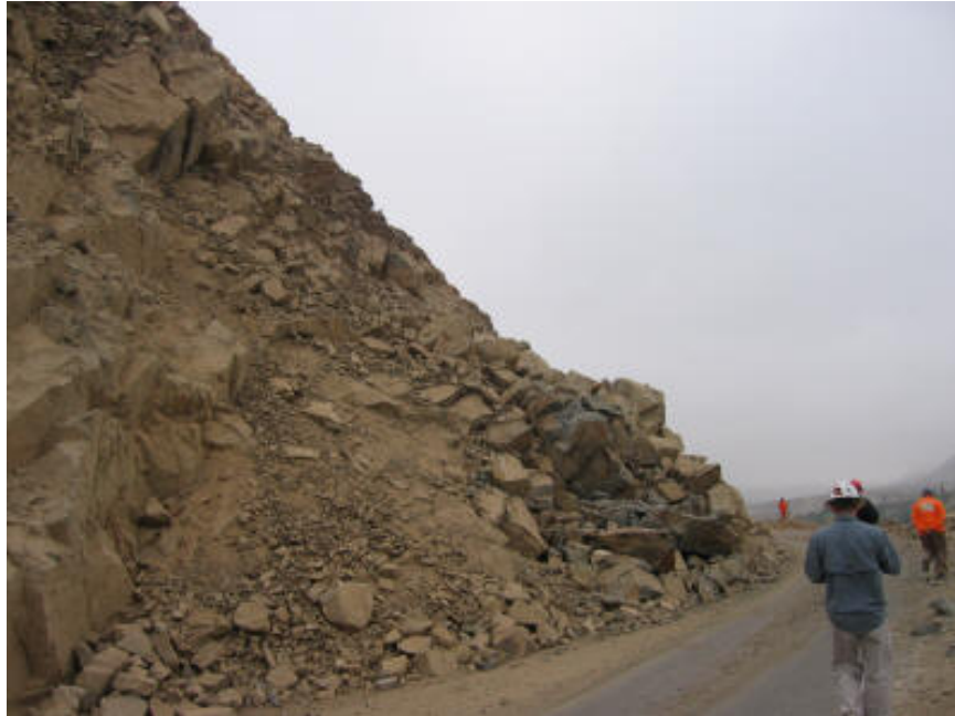
Figura 25: Deslizamiento de rocas en la carretera 024A.
