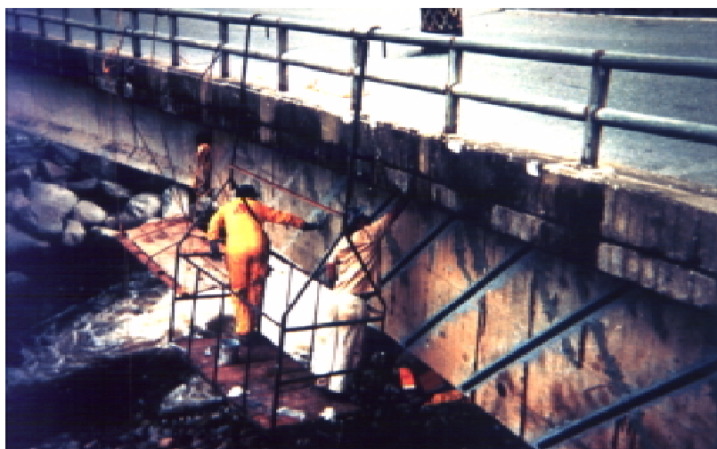
Figura 1.5: Colocación de refuerzo a esfuerzos cortantes en un puente.
