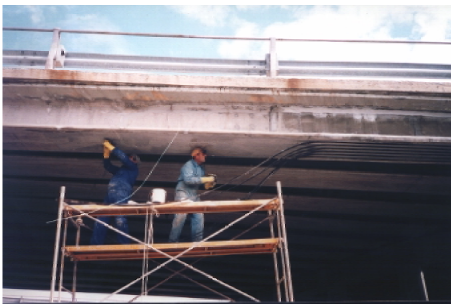
Figura 1.4: Colocación de refuerzo a flexión en viga lateral de un puente.
