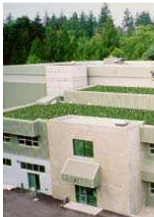
Figura 2. Techo verde del edificio
