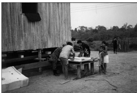
Figura 3: Comunitarios de São Francisco do Aiucá trabajando en el montaje de los módulos fotovoltaicos. [Foto: Roberto Zilles]
