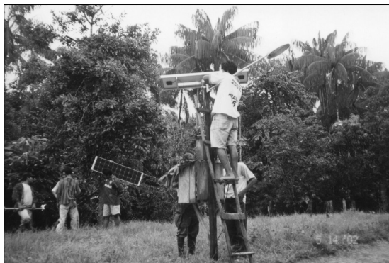
Figura 2: Pobladores de Vera Cruz efectuando la instalación de de un sistema de iluminación pública fotovoltaico. [Foto: Federico Morante]
