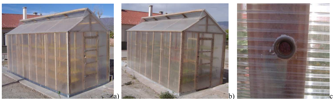
Figura 1: Secador solar de policarbonato y madera: mayo de 2004 (a) y mayo de 2005 (b). Oxidación de un clavo (c).
