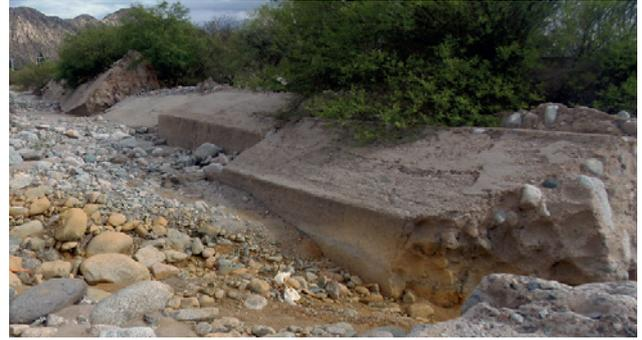
Figura 4 (superior). Detalle del muro actual volcado y destruido por la actividad erosiva
