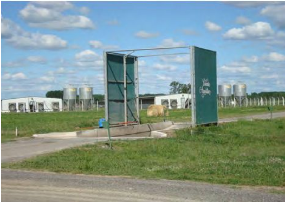
Foto 4. Rodoluvio para desinfección de vehículos
