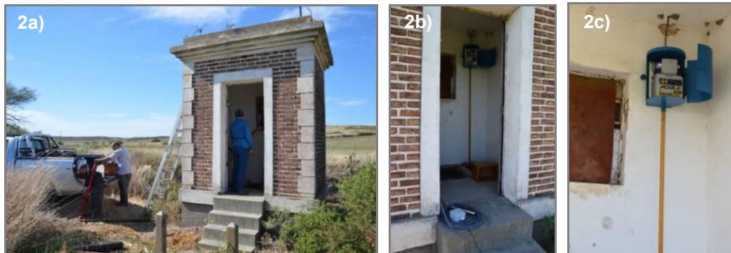
Figura 2. a) Estación de aforo de la PBA, b) vista del limnígrafo y c) abrigo antivandálico
