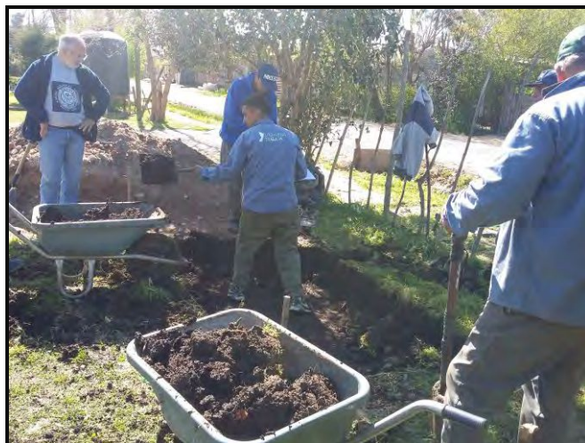
Figura 3.- Excavación del humedal por parte de los cooperativistas
