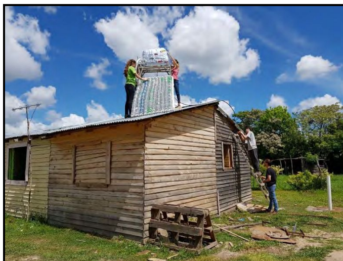
Figura 2.- Instalación del calentador solar
