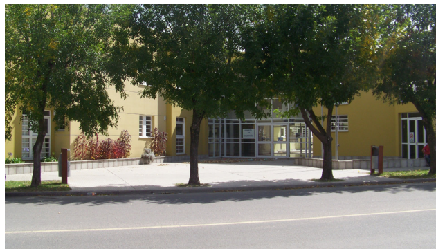
Vista frontal del ingreso al ISFT n° 194
