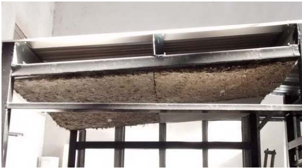
Fig. 7. Placas sujetas a tirantearía
