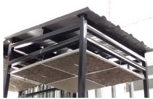
Fig. 8. Placas sujetas a estructura metálica
