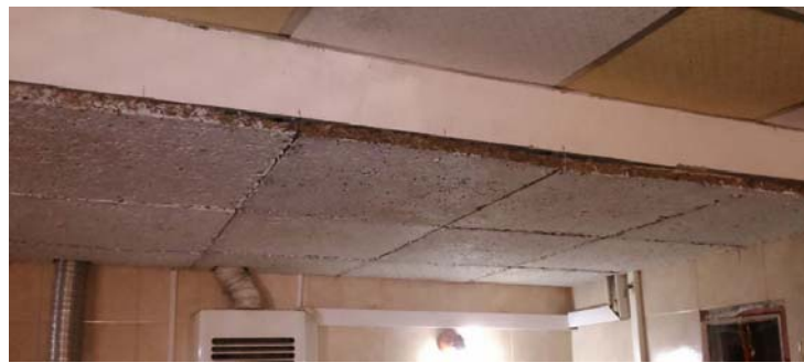
Fig. 9. Cielorraso ejecutado sobre construcción existente
