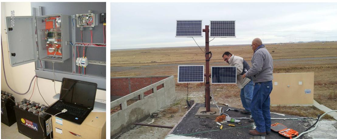
*Figura 1: Fotos del sistema, (a) Tablero para SISMED\_FV en AEA-UARG, y (b) Montaje de paneles en techo Lab. AEA.*
