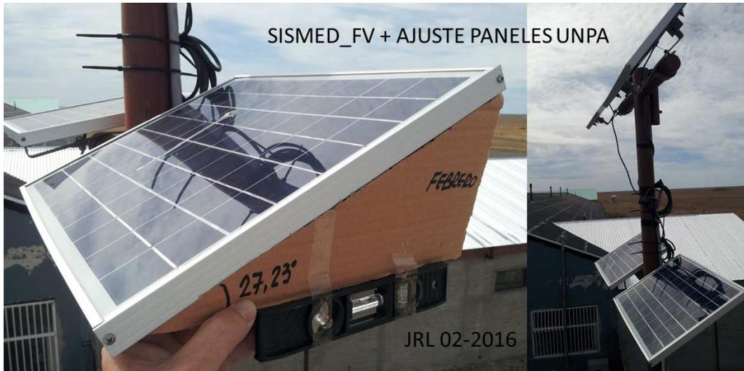
Figura 4: Ajuste del ángulo de los paneles inferiores, al ángulo óptimo (Foto – 02-2016)
