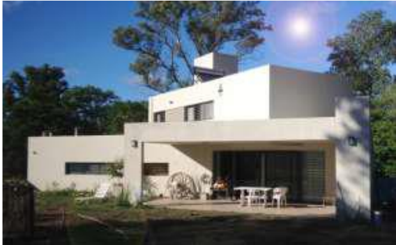
Figura 7. Caso de estudio vivienda con uso de colector solar
