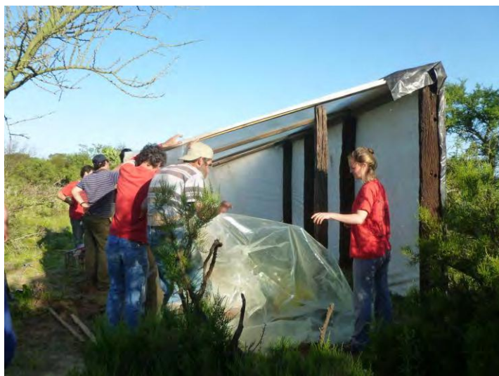
FIGURA 1. Invernadero construido con durmientes de ferrocarril y plástico de silo bolsa reutilizados. En la cobertura de la estructura participaron estudiantes de grado de Ingeniería Agronómica como parte de su formación en Agroecología, impartida por la Cátedra de Ecología Agrícola.
