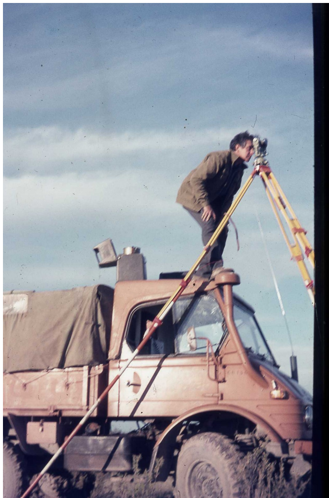
Figura 6. Godoy Bonnet realizando una medición. La utilización del vehículo para aumentar la altura de la visual pone de manifiesto la importancia que se le da a esta posición en el campo. Fuente: Donado por Godoy Bonnet a la autora.
