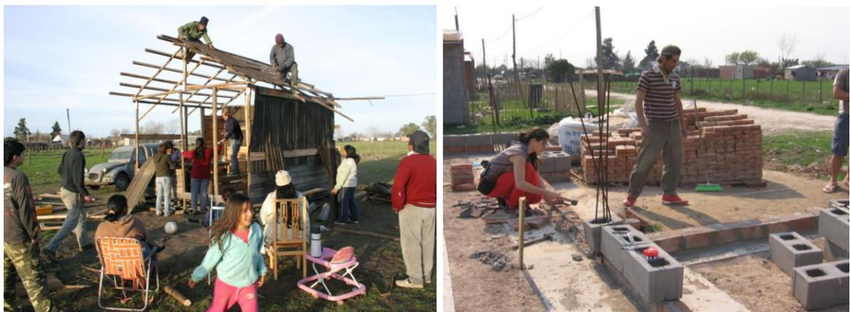
Fig. 1 y 2 – Construcción del Comedor provisorio. Y comienzo de los trabajos del Comedor definitivo
