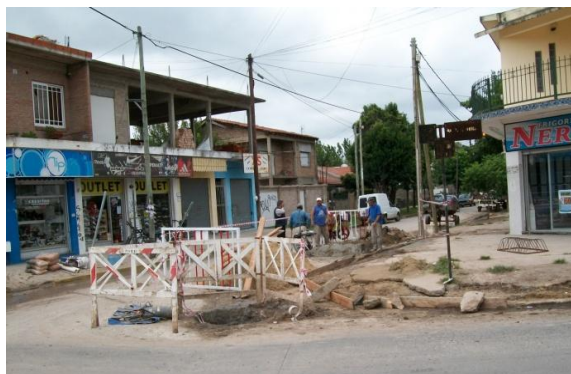
Fig. 9: Trabajos en la vía pública. OI
