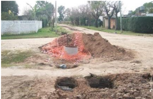
Fig. 13: Excavaciones en la vía pública. OI
