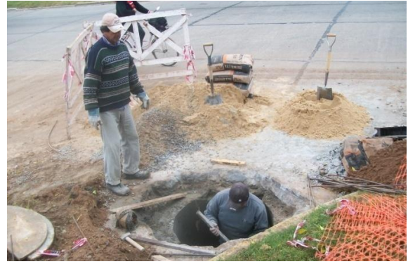
Fig. 12: Ejecución de tarea y zonificación de materiales. OI
