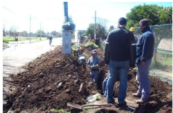
Fig. 10: Talud de excavación. OI
