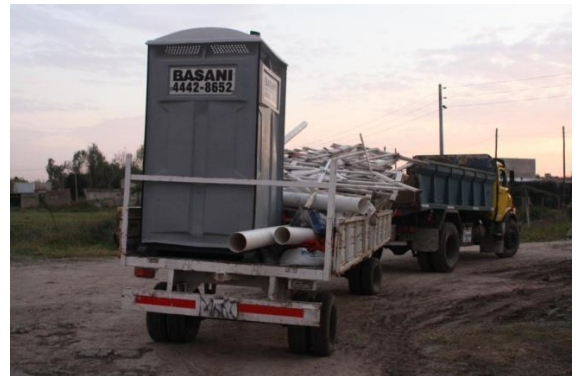
Fig. 16: Traslado de materiales e instalaciones auxiliares. OI
