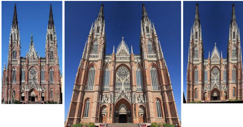
Fig. 4-164. La imagen de frente de la Catedral de la ciudad de La Plata, Argentina (izquierda), sirve como modelo para corregir la distorsión de la imagen central, producida por efecto de la lente gran angular de la cámara. Mediante un proceso de registro, es posible eliminar la distorsión (derecha).
