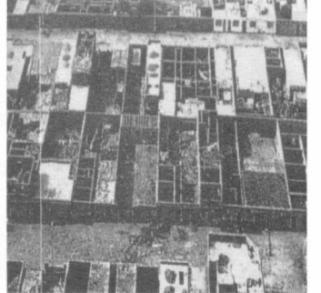
La construcción continuada en lotes.
