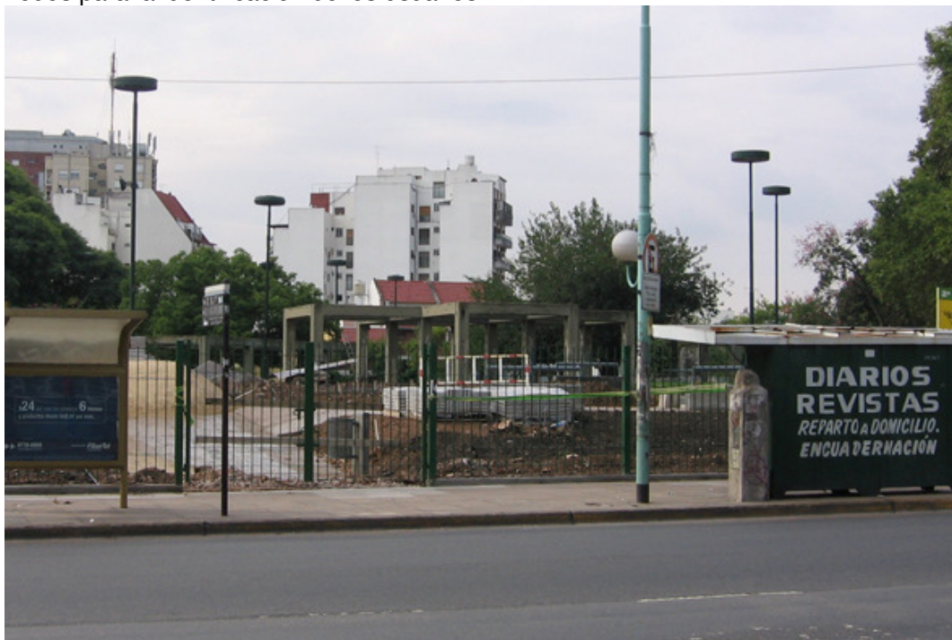
Vista previa la intervención del sector de la plaza FOTO: Pablo García Arabehty
