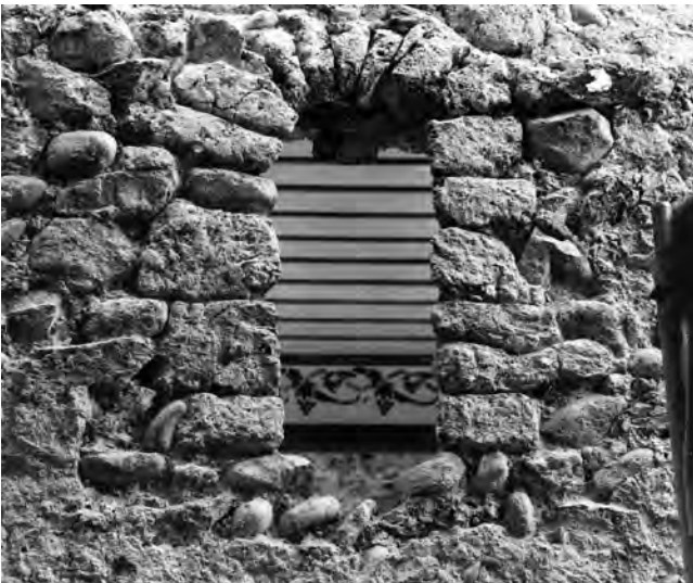
Abb. 229: Meikirch - Kirche 1977. Romanische Kirche. Fenster in der Nordfassade des Schiffes. Blick nach Süden.
