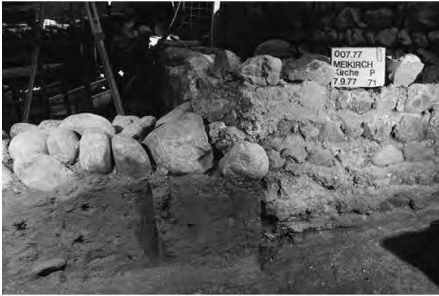
Abb. 52: Meikirch - Kirche 1977. Die neu errichtete und tiefer fundamentierte Mauer 271 stösst von rechts an die Rollierung der Mauer 266. Teilweise überdeckt der Mörtel der Mauer 271 die Rollierungssteine 266. Blick nach Osten.
