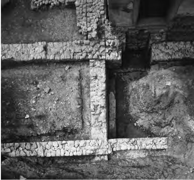
Abb. 58: Meikirch - Kirche 1977. Portikus 6 und Kryptoportikus 15. Der Durchgang in der Längsmauer 202 (oben rechts) führt von der Kryptoportikus 15 (unten) in das Treppenhaus 8 (oben). Die Quermauer 204 in der Bildmitte trennt die Kryptoportikus 15 von der westlich angrenzenden Portikus 6. Senkrechtaufnahme, Norden oben.
