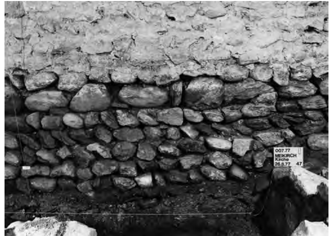
Abb. 231: Meikirch - Kirche 1977. Romanische Kirche. Fundament der Südwall des Kirchenschiffes. Blick nach Süden.
