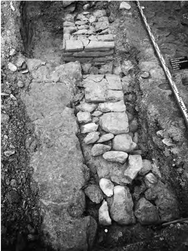
Abb. 39: Meikirch - Kirchgemeindehaus 2001. Raum 17. Die Mauern 171 und 172 (vorne rechts) bilden die Südwestecke des Raums. Im Innern dieser Mauerecke ist ein schmaler Streifen des Steinkoffers 174 freigelegt. Im Hintergrund ist der Durchlass 173 erkennbar. Links befindet sich eine neuzeitliche Mauer. Blick nach Norden.
