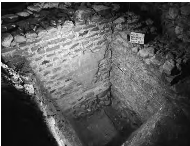
Abb. 51: Meikirch - Kirche 1977. Die Mauer 256 (hinten links) enthält zwei Lagen von Ziegeldurchschüssen (zweite und vierte Lage von oben). Gut sichtbar ist der Fugenstrich, der oberhalb des Vorfundamentes mit Verputz überdeckt war. Blick nach Nordwesten.
