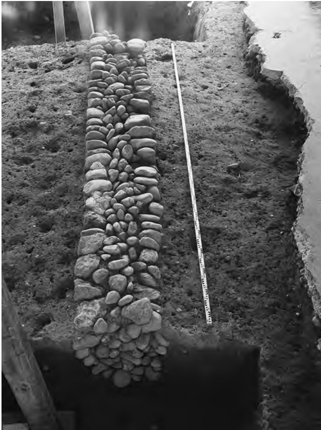
Abb. 65: Meikirch - Kirchgemeindehaus 2000. Von der nördlich der Villa gelegenen, hangparallelen langen Mauer 1 ist nur die Rollierung erhalten geblieben. Blick nach Westen.
