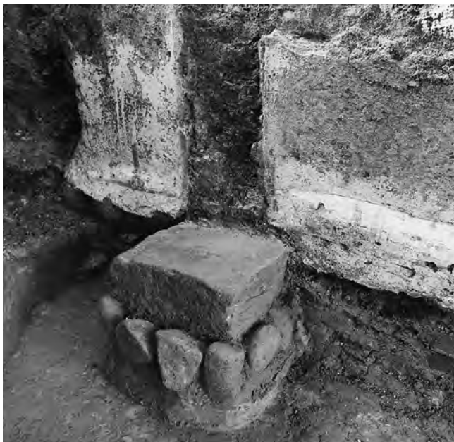
Abb. 44: Meikirch - Kirche 1977. Kryptoportikus 15. Entlang der Nordwand stehen in regelmässigen Abständen Pilastersockel. Über dem Fundament aus Gerölln liegt eine fache Platte aus kristallinem Gestein. Blick nach Nordwesten.
