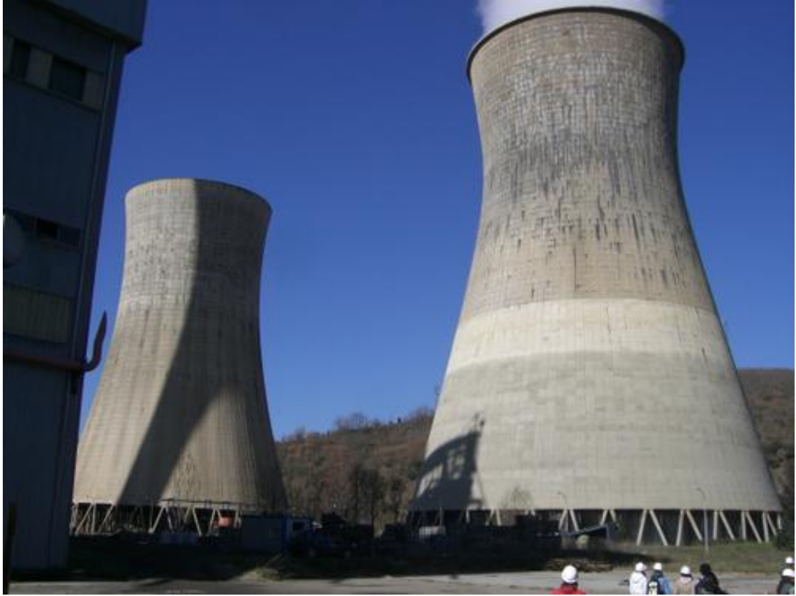
Figura 5.4: Torres industriales hiperbólicas de tiro natural
