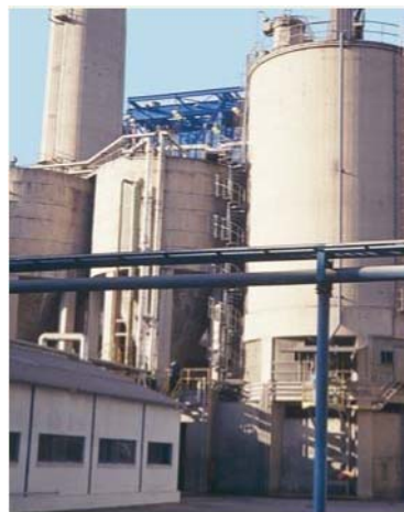
Figura 2.12: Silos de cenizas y escoria de la C.T. de La Robla – Grupo I
