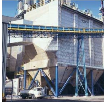
Figura 2.10: Precipitadores electrostáticos de la C.T. de La Robla – Grupo I
