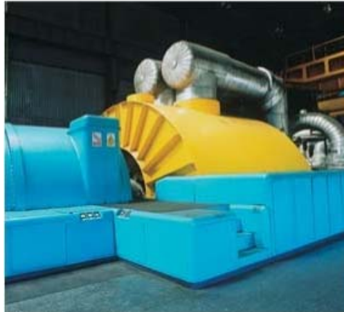
Figura 2.15: Cuerpo de alta presión de la turbina de La C.T. de La Robla – Grupo I
