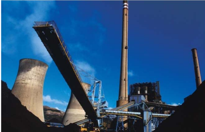
Figura 2.11: Chimenea de la C.T. de La Robla – Gupo I
