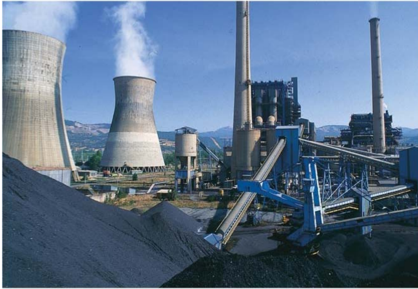
Figura 2.5: Vista de la C.T. de La Robla desde el Parque de carbón
