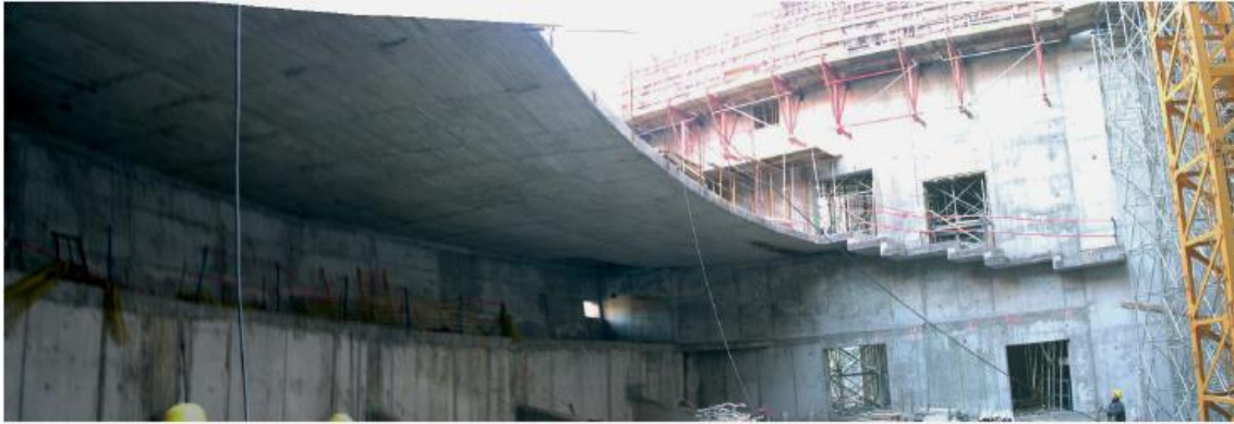
Fig 2. Forjado de un edificio
