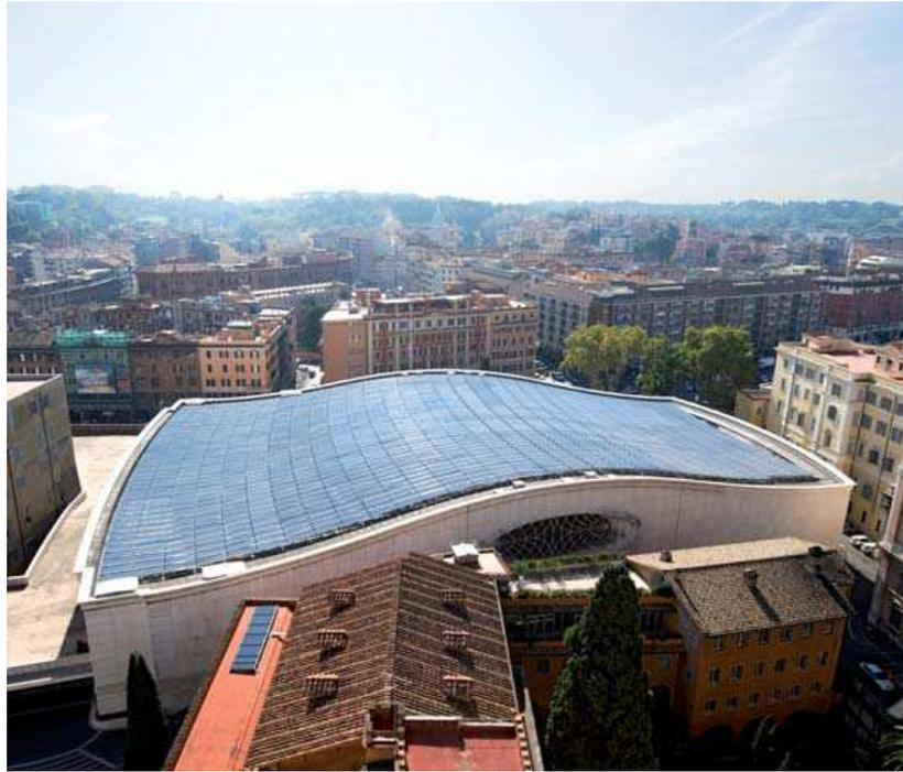
**Figura 3: Instalación fotovoltaica del Vaticano. Fuente: SMA**
