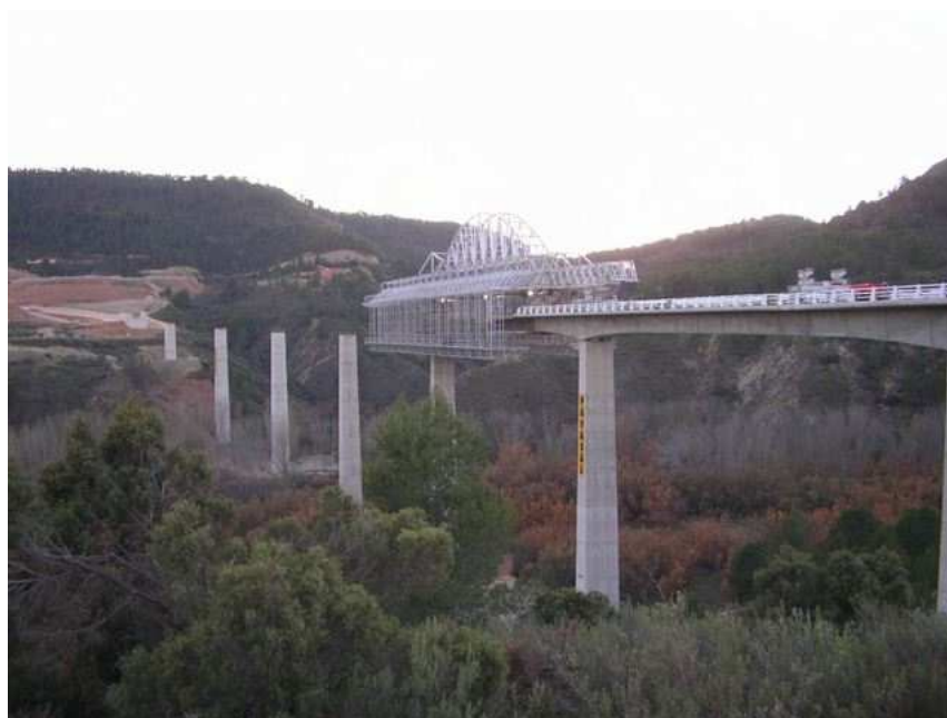
Fig. 2.14. Cimbra autolanzable para viaducto
