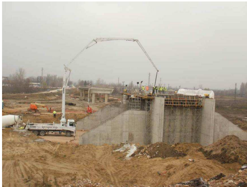
Fig. 2.1. Hormigonado del tablero de un paso superior
