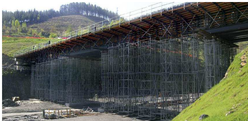
Fig. 2.19. Puente cimbrado con paso porticado y salvataludes
