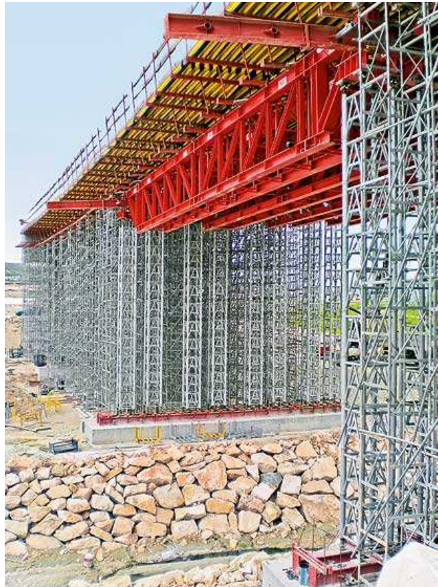
Fig. 2.18. Viga de celosía para paso de vehículos
