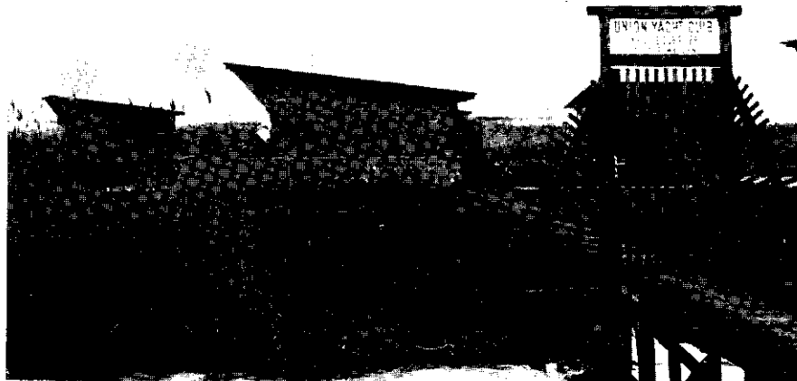
25. Zomerhuisjes van rietplaten aan het Meer van Neusiedl. Deze huisjes staan op de grens van het riet en het water.
