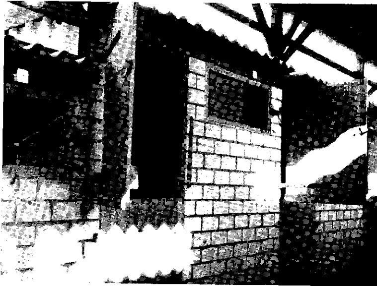
7. Detail van de openstaande deuren en ramen naar de middengang, waardoor er een ruime mogelijkheid is voor natuurlijke ventilatie (Sauna-stal)
