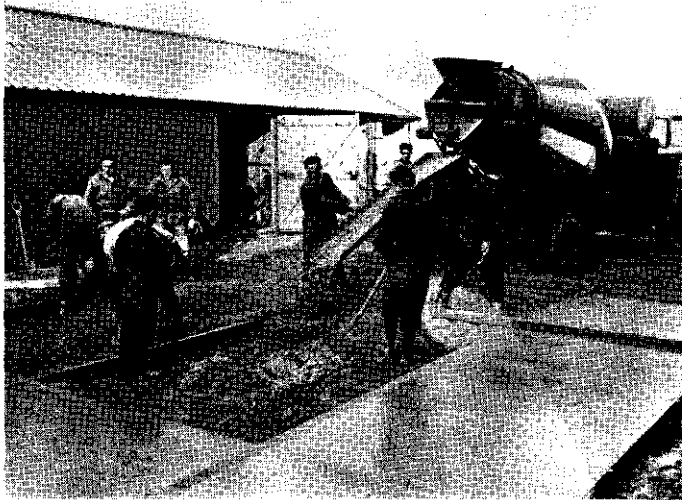
AFB. 9. Aanleg van erfverharding van ongewapend beton. De mortel wordt aangevoerd van een betonmortelcentrale.
