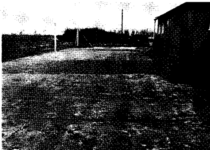
AFB. 24. Overzicht van een aantal proefvakken met zand-cementstabilisatie.
