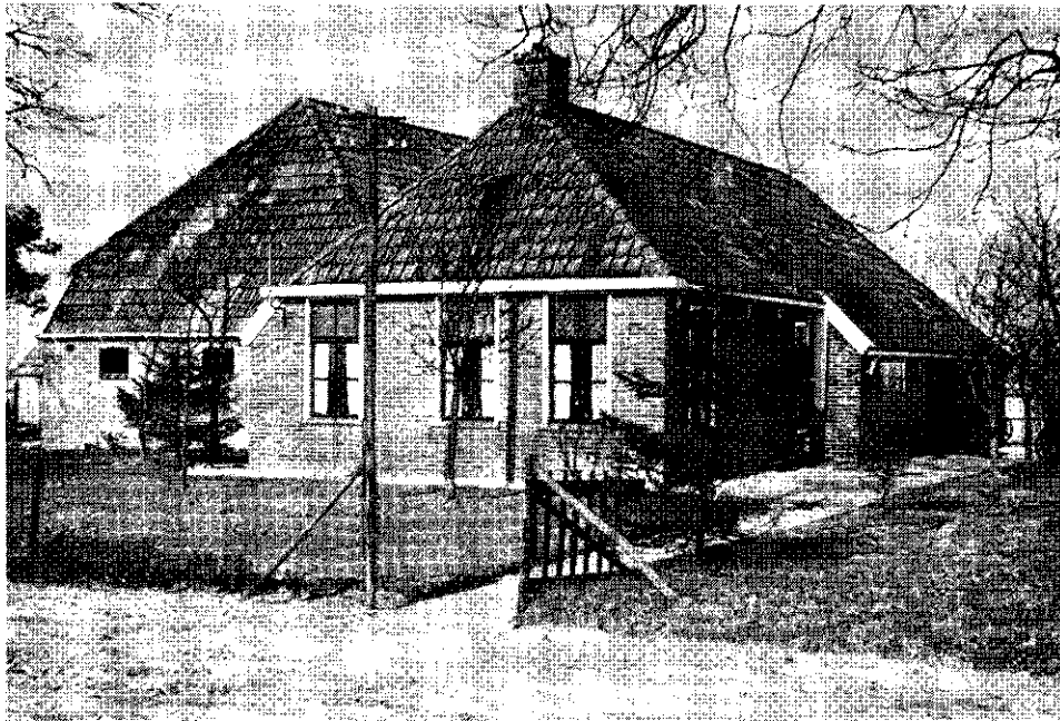
Afb. 52 De gebouwen van bedrijf 2.
