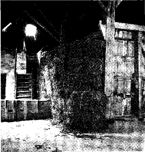
Geïmproviseerde bewaring onder dak. Isolatie gedeeltelijk met stropakken, en in geval van strenge vorst, met extra zeilen en zakken. Het hoofdkanaal loopt over de schuurdeel. Interne koeling met schuurlicht is mogelijk
