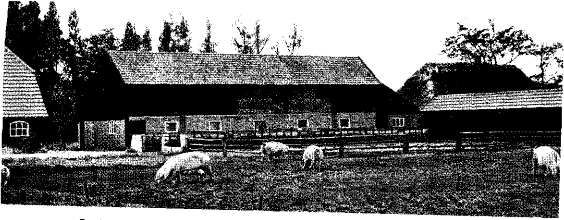
Dit bedrijf heeft de melkkoeien opgeruimd. Onder een veldschuur is een opfokstal gebouwd
