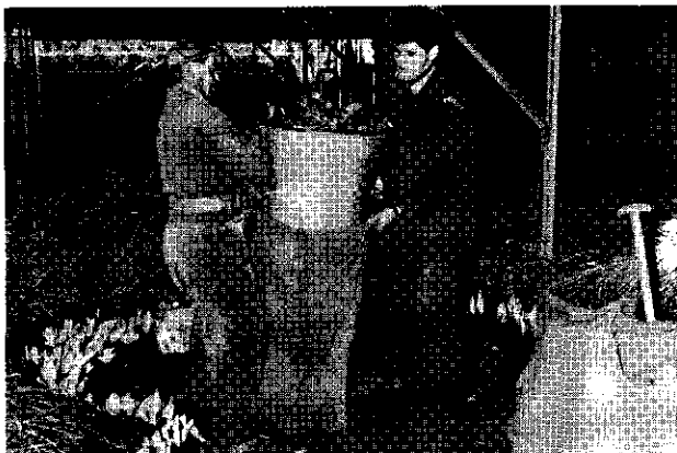
afb. 16. bij het transport in zakken moeten voor verschillende onderdelen meerdere personen tegelijk worden in- geschakeld. de foto toont het optrekken van de bodemloze ton.
