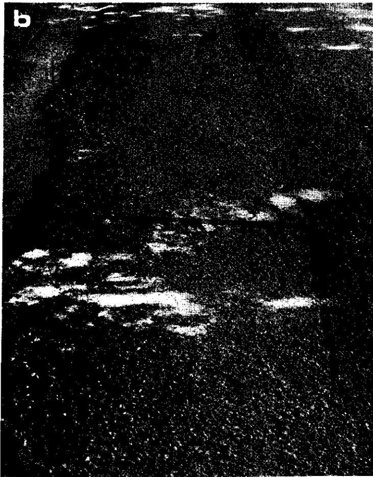
Fig. 17. Een aantal vormen van rijdekbeschadiging die, indien niet tijdig actie wordt ondernomen, ter plaatse de destructie van de verharding inluiden
