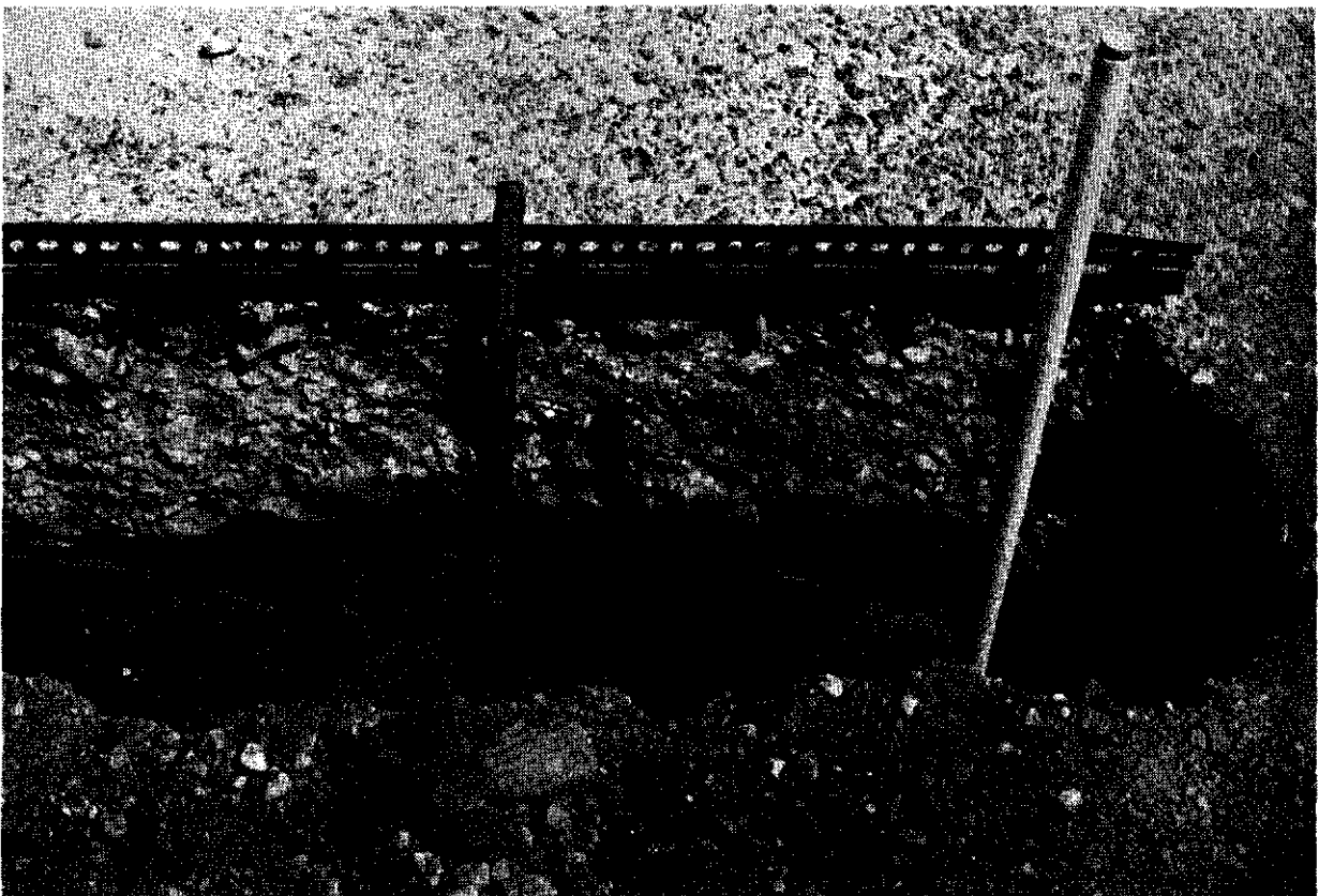
Fig. 8. Dwarssleuf in de verharding van weg 172
