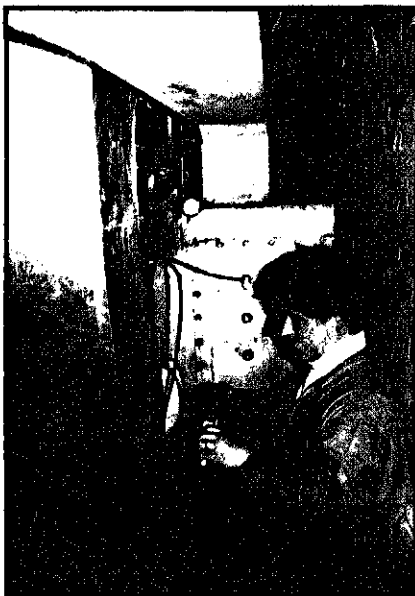
Als u centraal gaat doseren, moeten aan de installatie hoge eisen worden gesteld. Zo zal ook het afstellen van de brander zeer nauwkeurig moeten gebeuren. Bij modulerende regeling minstens 10 standen controleren.
