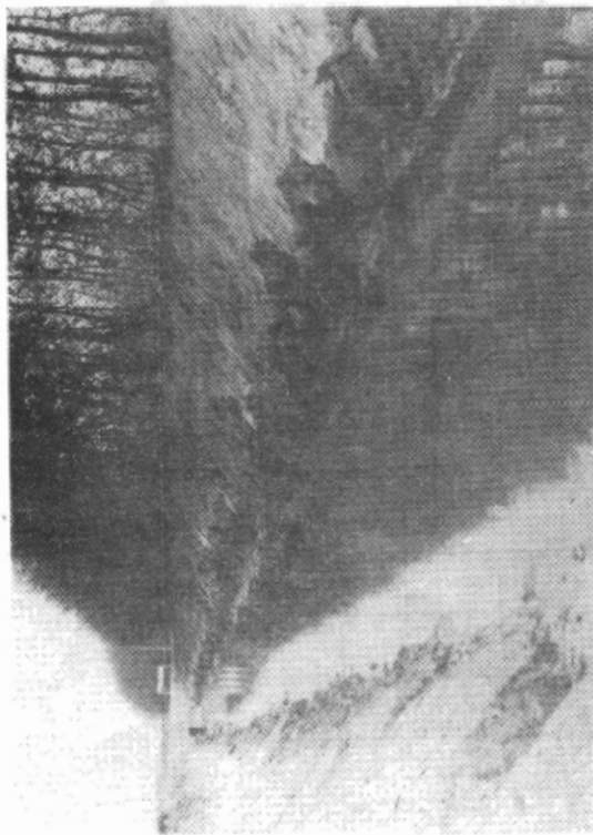
Fig. 5. Afschuiving van de taluds door kwel na doorgraving van een leemlaag bij een breukvlak
