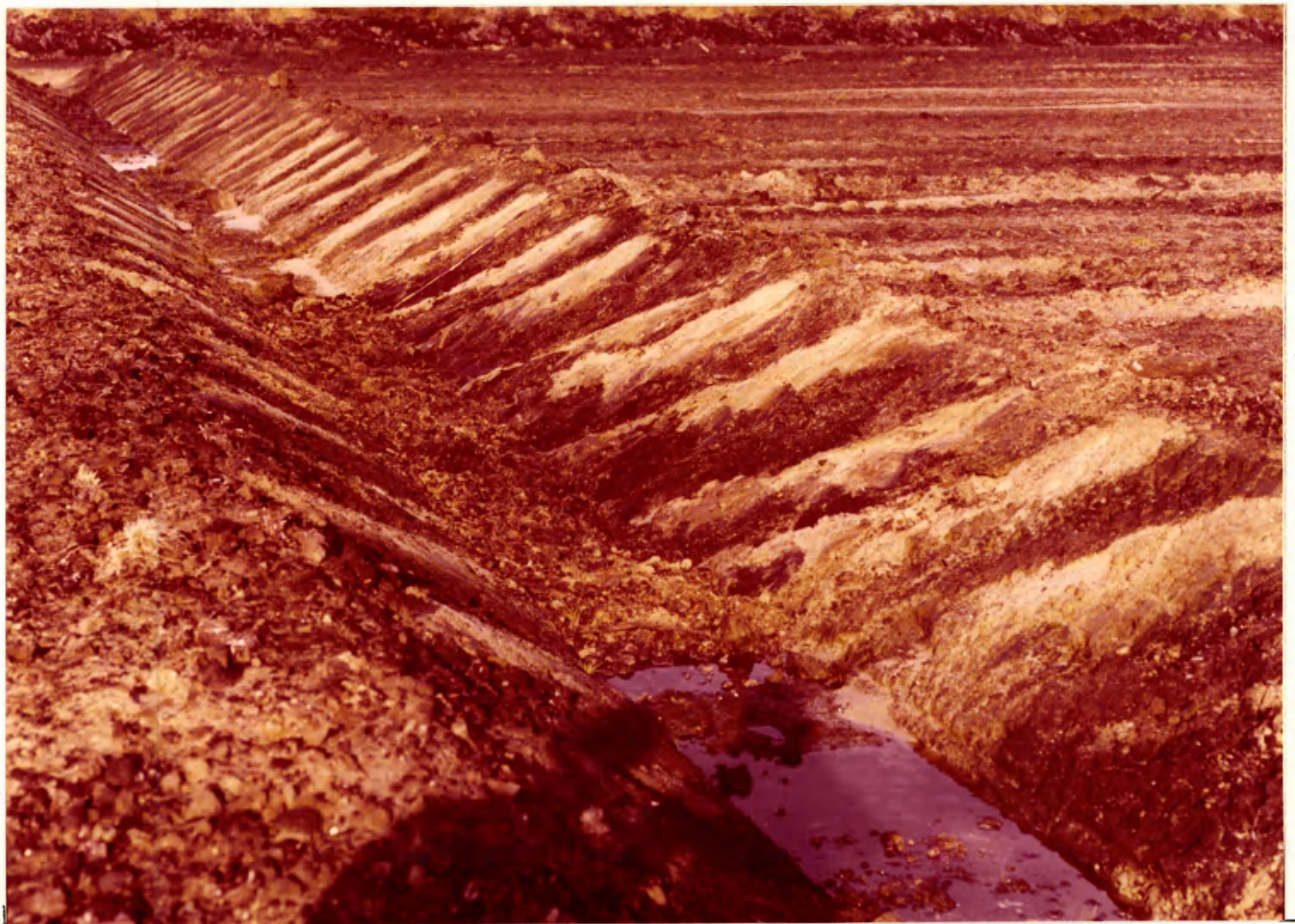
Afb. 3 Overzichtopname van het gediepploegde gedeelte.
