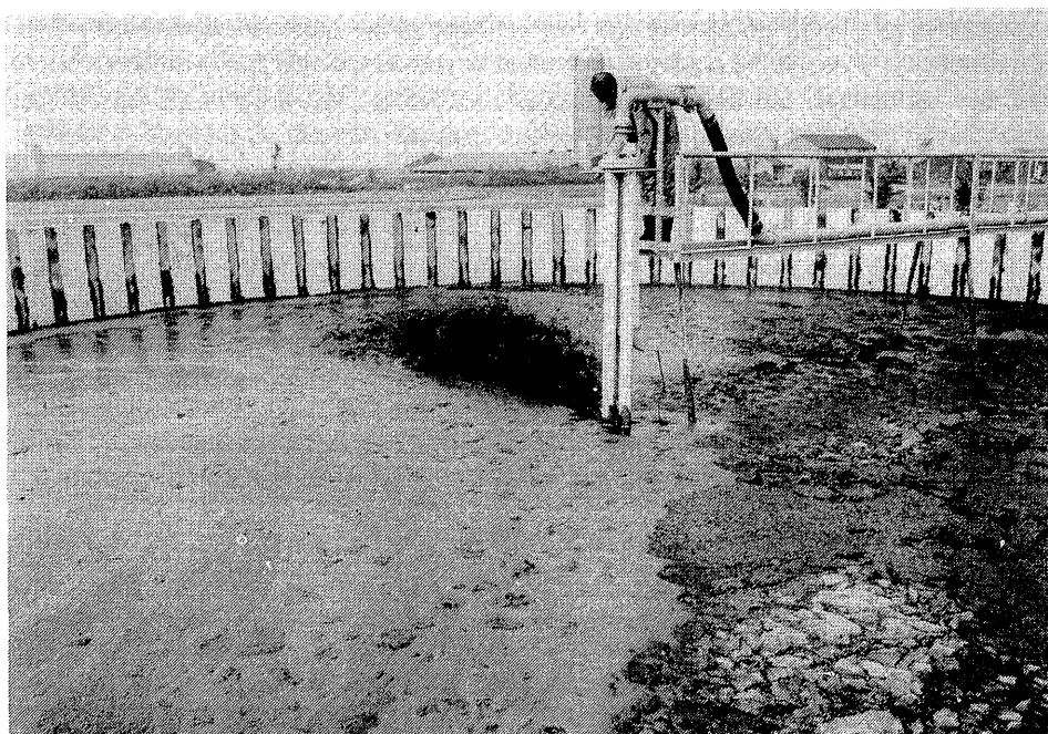
Met een Beham-pomp en een centraal in de silo opgesteld terugspuitapparaat met verschillende spuitkoppen kan de mest worden gemengd en is een eventuele drijfslag goed te breken.
