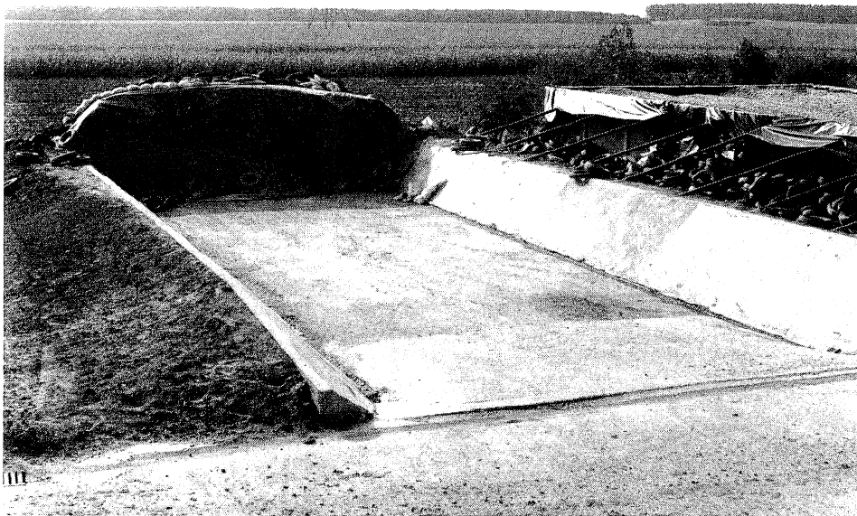
Figuur 1 Gewapend betonnen sleufsilo's voor de opslag van snijmais met schuine wanden, gestort tegen een grondwal.
