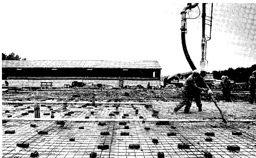
De bouw van afdeling 2 is in volle gang. Hier is de vloer aan de beurt.
