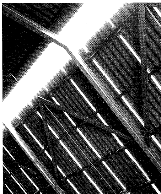
Dakspleetventilatie op Melkvee 4; elke spleet is 1 1/3 cm breed.
