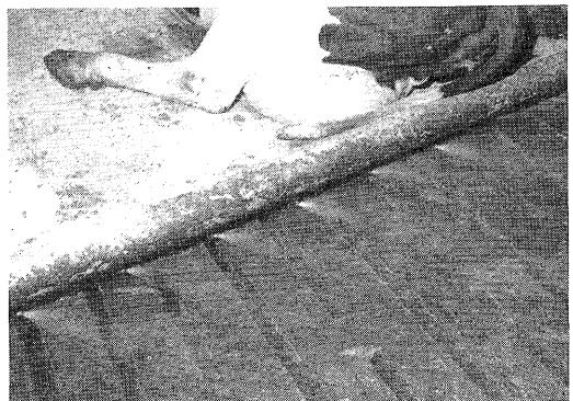
Spoelsysteem in een ligboxenstal
