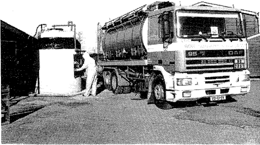
Vullen van het vat met aanzuurmiddel.
