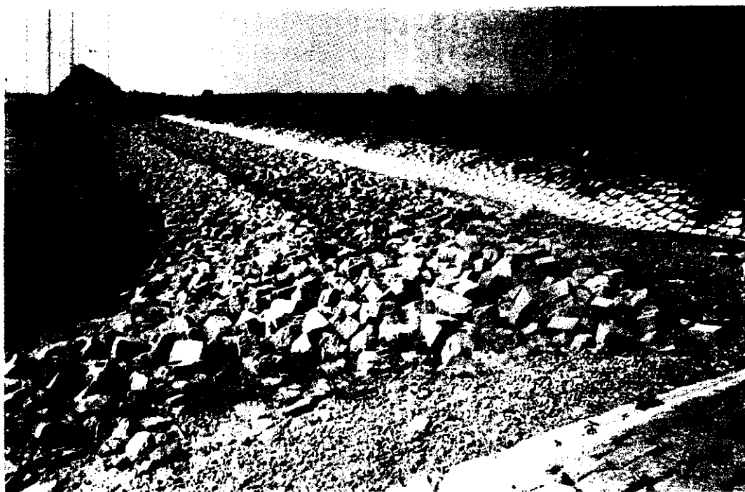
Foto 17 Het vastleggen van de Waal oevers met stortsteen betekent het einde van het dynamische oevermilieu
