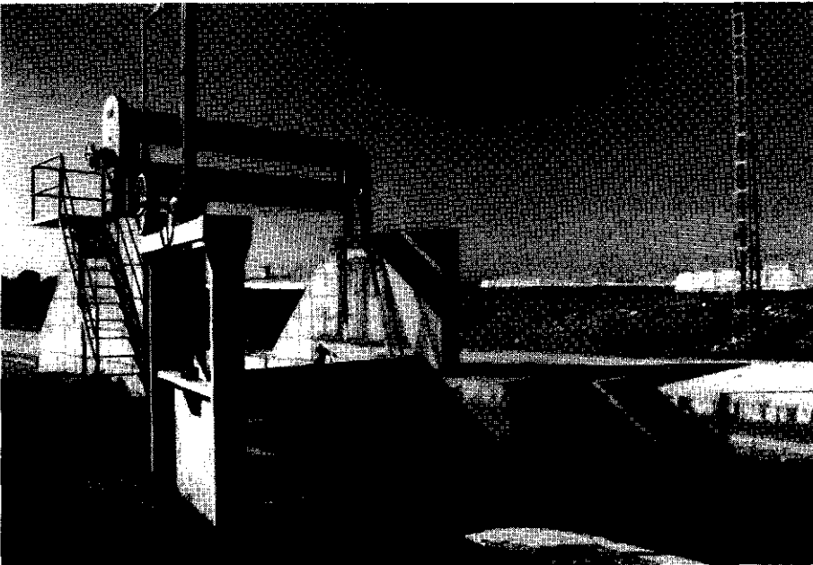
Een peilregulator in het aanvoerkanaal van het irrigatiesysteem in de Campo de Cartagena
