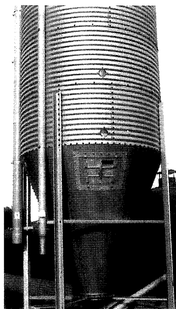
Manluik in een silo.
