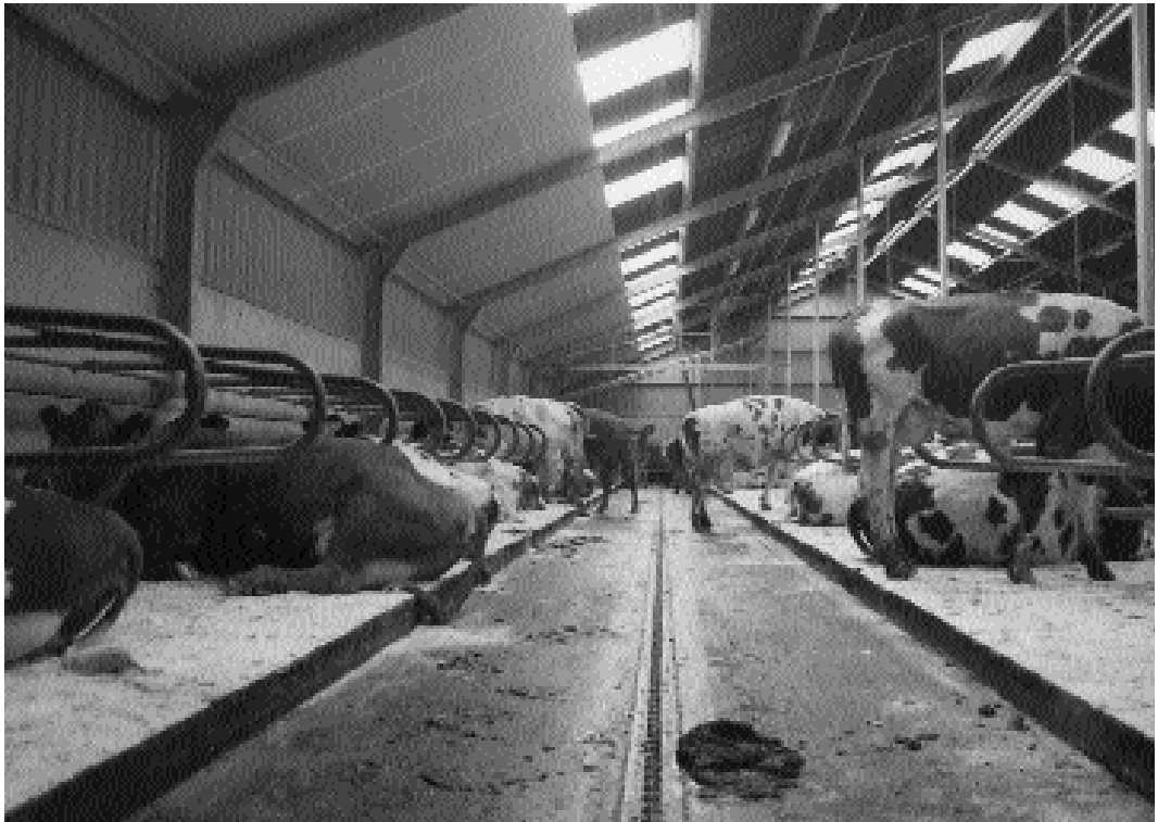
De mestgangen zijn voorzien van hellende vloeren met een giergoot in het midden.
