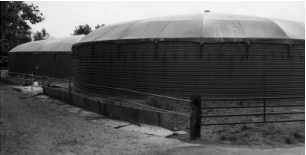
Beide bedrijven beschikten over een afgedekte mestopslag van 700 m 3 .
